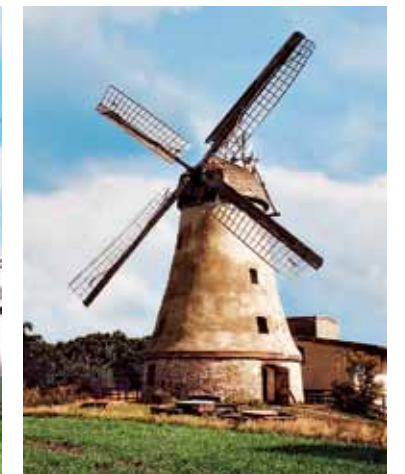
Die restaurierte Mühle nach ihrer Fertigstellung im Jahre 1994: mit Kappe und Flügeln.
