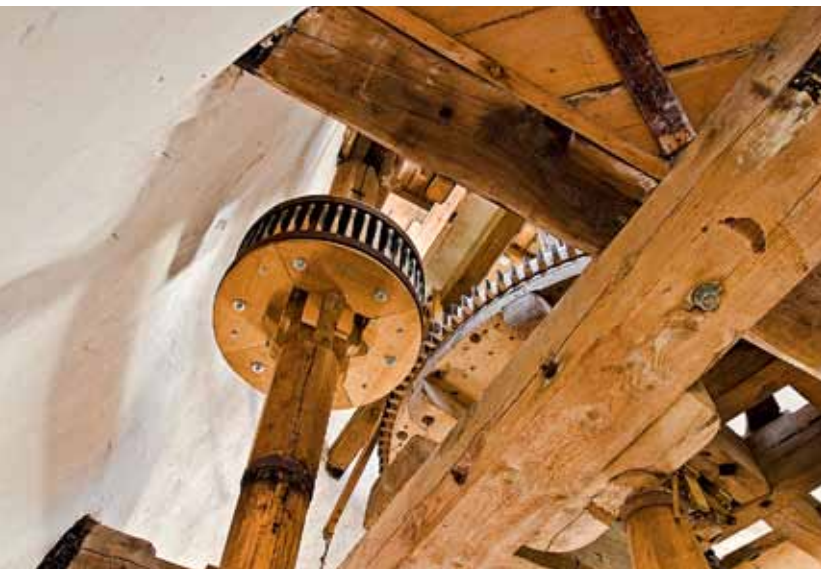
Oben: In der Mühlenkappe ist das große Kammrad auf der Flügelwelle zu sehen. Mit dem hölzernen Ring wird die Mühle bei Bedarf gebremst. Unten: Vom Mahlboden aus ist das Stirnrad zu erkennen, in welches das Korbrad eingekuppelt werden kann. Es treibt den Mühlstein an.
