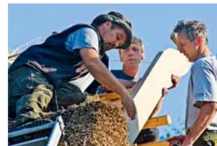
Am Ende wird der Dachfirst montiert. Dazu sind mehrere Hände nötig.
