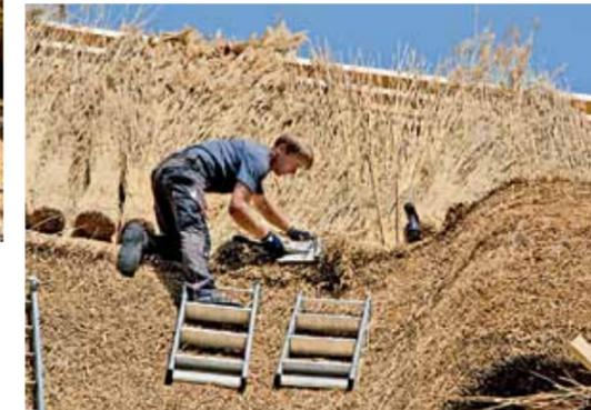
Das Reet muss auf die richtige Länge gebracht werden, damit es eine einheitliche Fläche auf dem Dach bildet.
