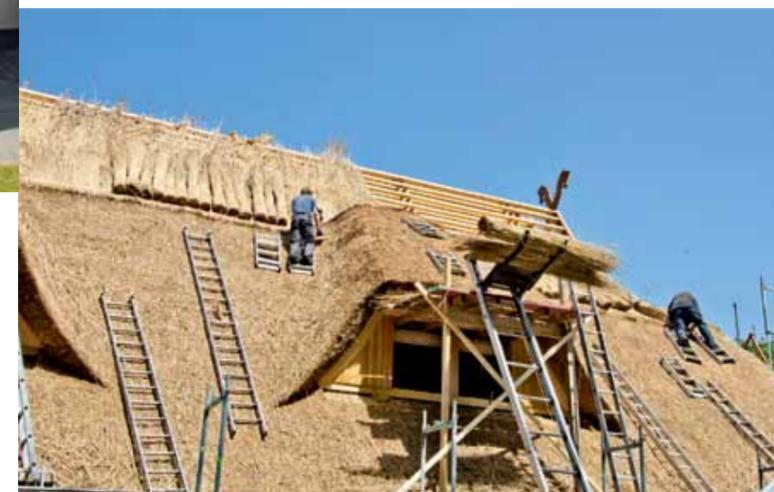
Die Eindeckung eines Hauses mit einer Dachfläche von ca. 200 Quadratmetern kann zwei bis drei Wochen dauern.
