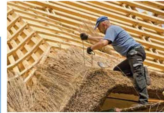
Sorgfältig wird das Naturmaterial auf dem Unterbau angebracht. Adam Klos schichtet die Halme dicht an dicht.
