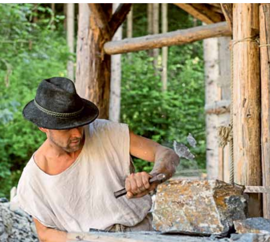
Der Steinmetz arbeitete vom Groben hin zum Filigranen mit Pickle, Flächhammer sowie Meißel und Spitzseisen.
