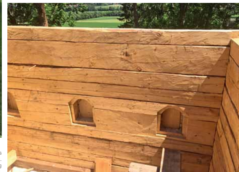
Die Blockstube im Wintergeschoss des Wohnturmes wurde aus Fichten- und Lärchenholz gefertigt. Holzbalken werden als traditionelle Verbindung waagrecht übereinandergesetzt.
